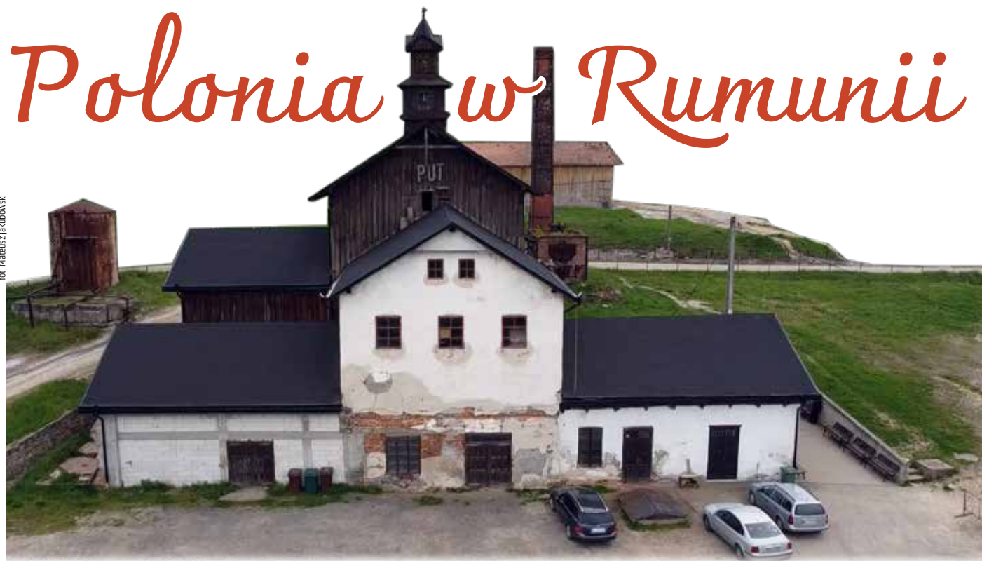
Budynek kopalni soli
